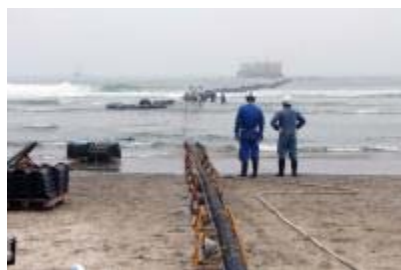
海底ケーブル敷設
