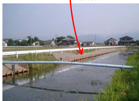
【木柵工による護岸整備】
