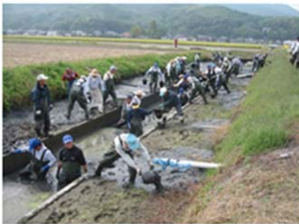
【水路の泥上げ】
