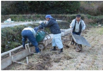
【地域住民による畦畔整備】
