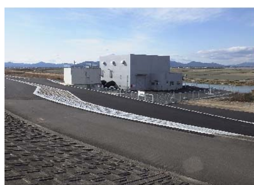
写真 2：地盤沈下による湛水被害を解消するために建設された排水機場（白石平野地区）
