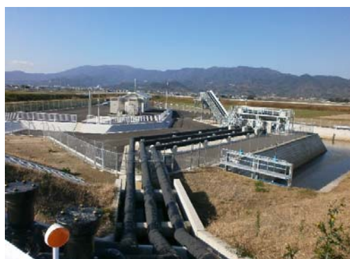
写真 2：地盤沈下による湛水被害を解消するために建設された排水機場（白石平野地区）
