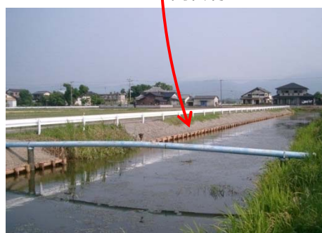
【木柵工による護岸整備】
