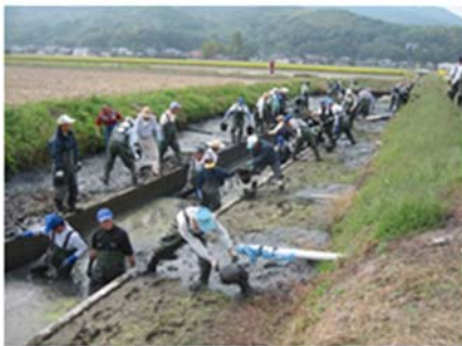
【水路の泥上げ】
