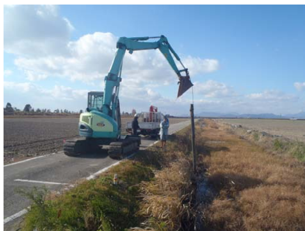
写真-1 クリーク防災杭の引抜状況(川副町犬井道)
