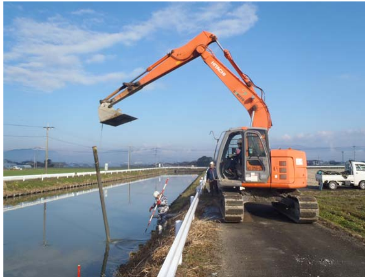
写真-2 クリーク防災杭の採取状況(神崎市千代田町)
