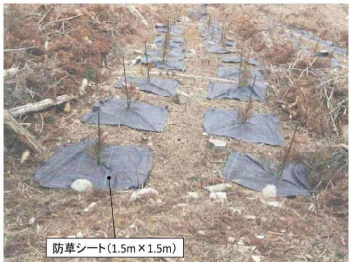
写真-2 マルチ区防草シート設置状況 (植栽時)
