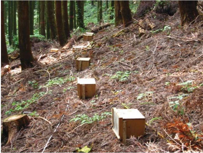
写真-1 土砂受け箱の設置状況
