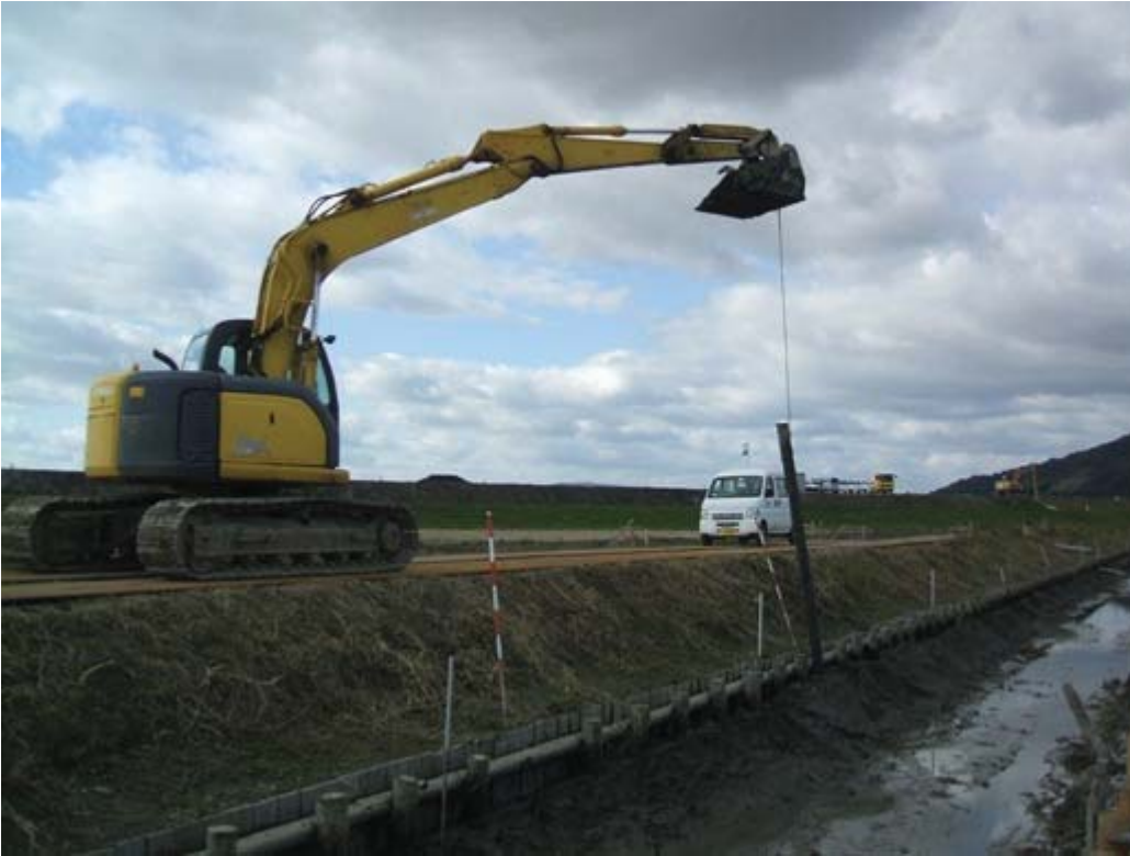
図-2 クリーク防災杭の採取状況(小城地区水路)
