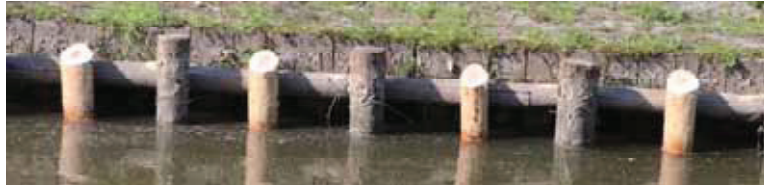
杭頭加工( 斜め切り)
