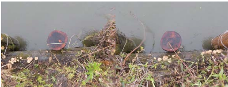
杭頭焼き加工杭
