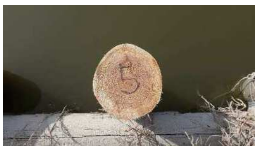
写真-4 水性キシラモン3W+10%CNF塗布杭
