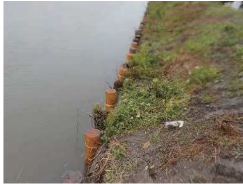
写真一八 令和2年度施工地(佐賀市北川副町江上)
