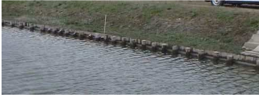
写真一七 令和元年度施工地(佐賀市巨勢町修理田)
