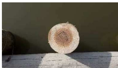
写真-5 水性キシラモン3W+1.7%CNF塗布杭
