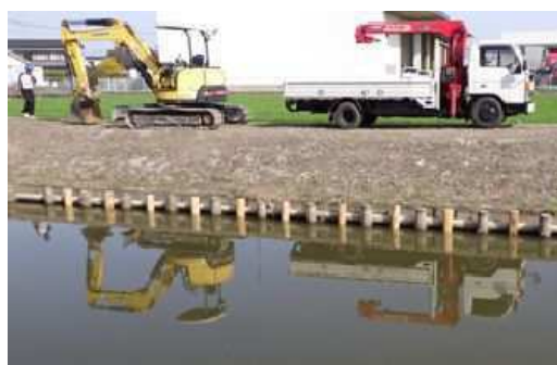
写真－3 令和3年度施工地(佐賀市巨勢町修理田)
