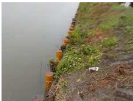
写真－2 令和2年度施工地(佐賀市北川副町江上)
