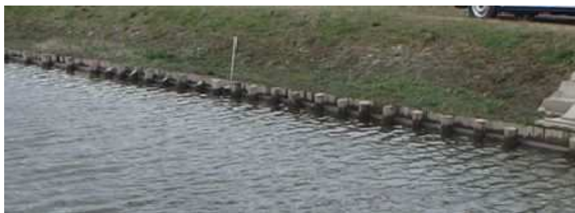
写真－1 令和元年度施工地(佐賀市巨勢町修理田)
