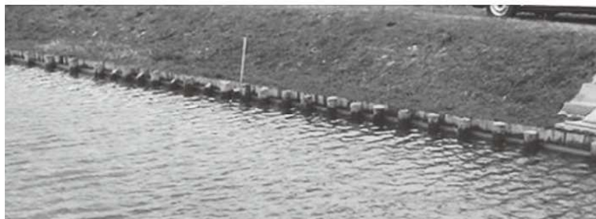
写真－1 令和1年度施工地(佐賀市巨勢町修理田)
