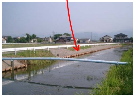
【木柵工による護岸整備】
