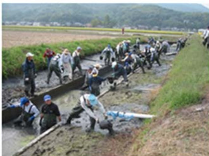
【水路の泥上げ】
