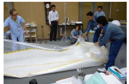
図_2 - 17 養生シートの撤去
