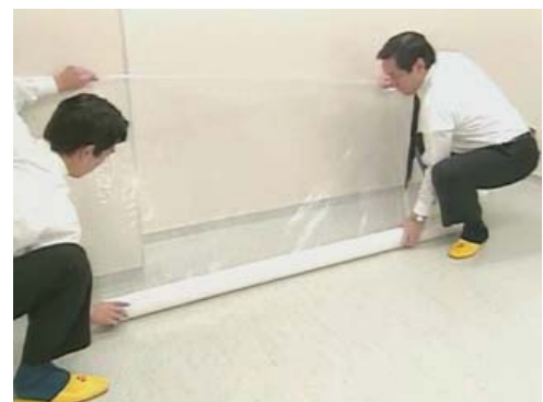
図_2 - 8 壁面養生の例
