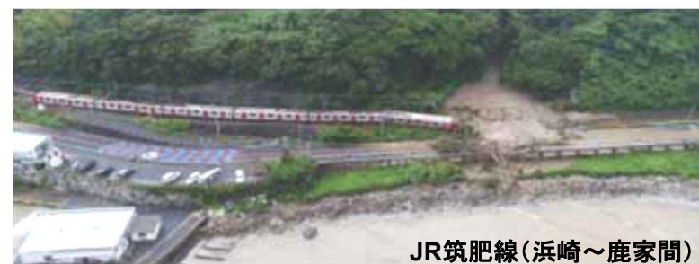
平成30年7月豪雨 佐賀県被害
