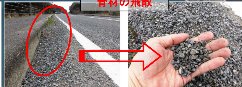
骨材の飛散
