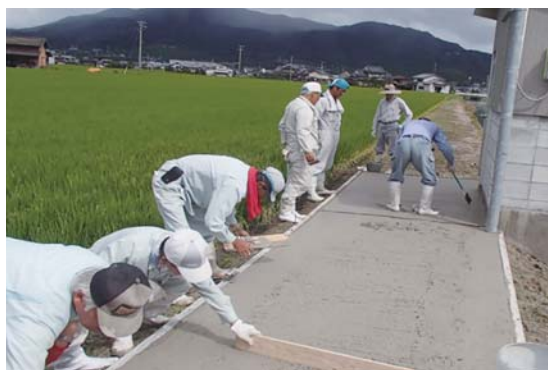
地域ぐるみの取組による農道舗装
