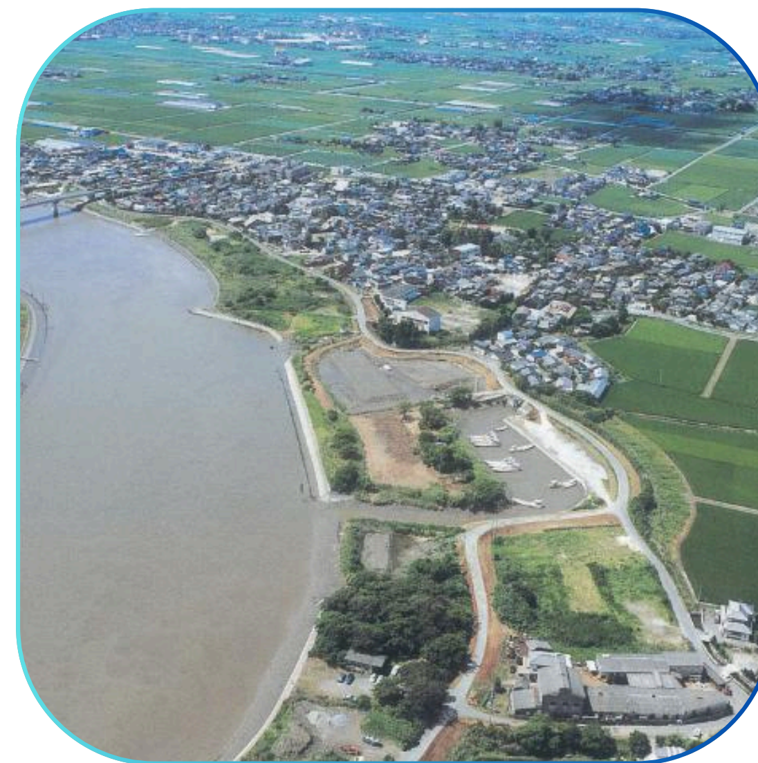
三重津海軍所跡ガイダンス施設 改修工事(電気)
