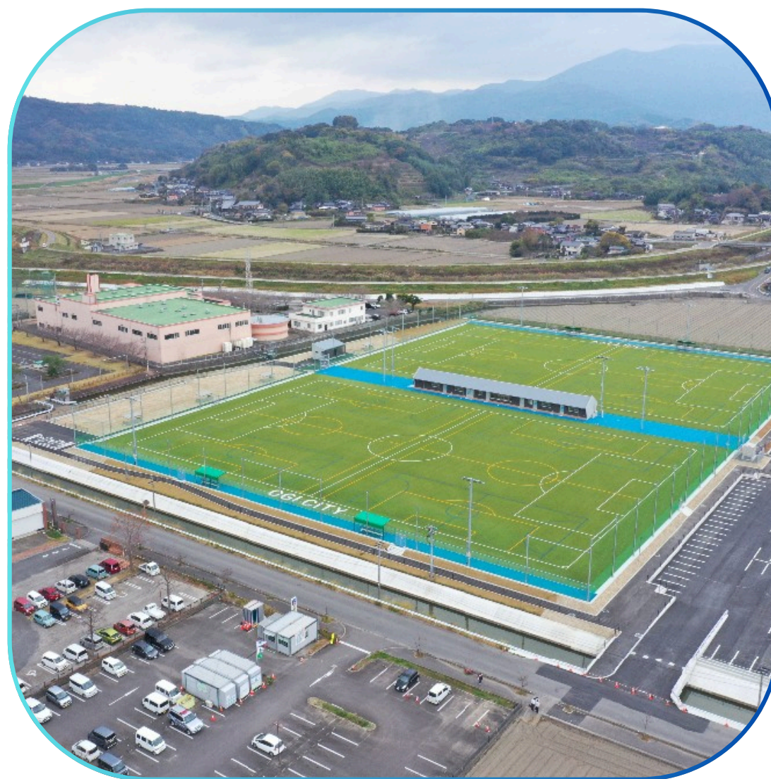
ブラックモンブランフットボールセンター 整備事業電気設備工
