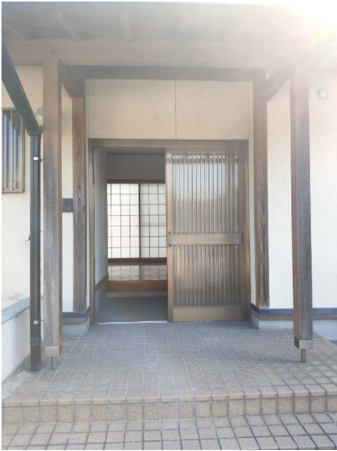
旧諸富警察署長宿舎 (1351 号) 屋内写真
