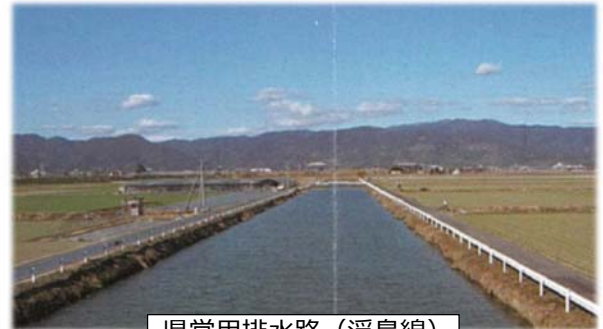
県営用排水路 (浮島線)
