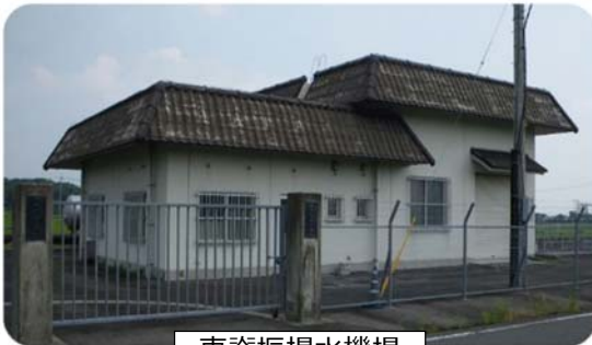
東脊振揚水機場
