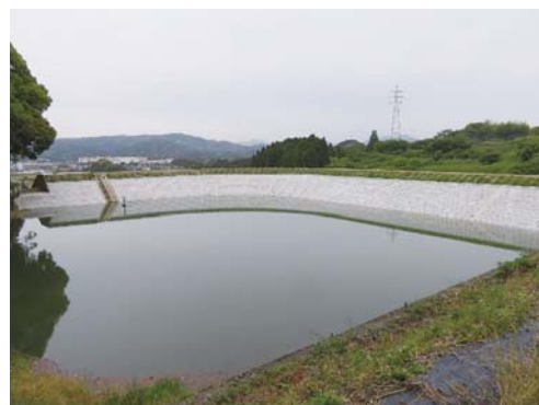
整備されたため池
