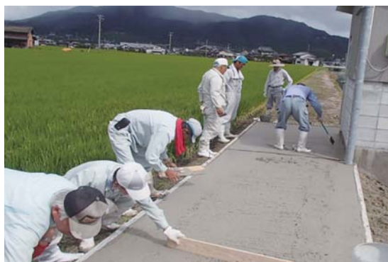
地域ぐるみの取組による農道舗装
