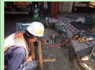
【検査状況（現場側）】
