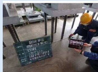
【検査状況（現場側）】
