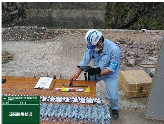
【立会状況 (現場側)】
