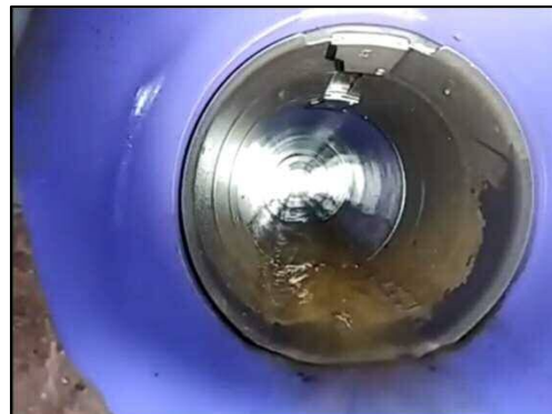
【オンライン検査（管の通り確認）】
