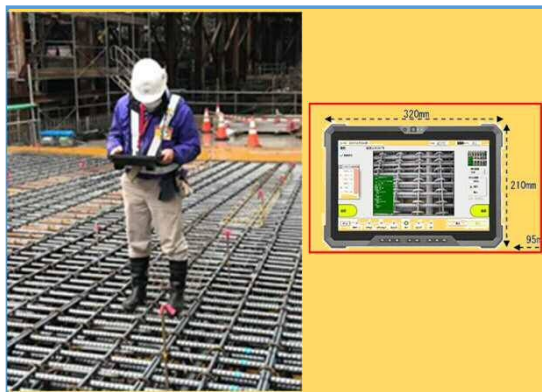
【立会状況（現場側イメージ）】
