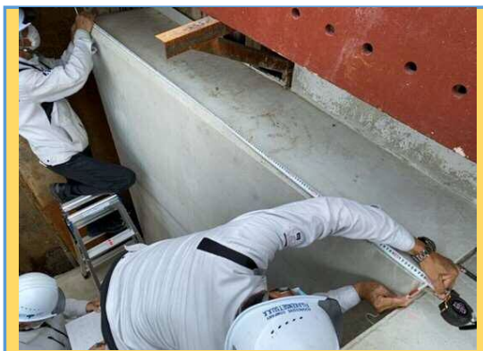
【立会状況（現場側）】
