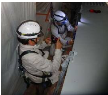
【測定箇所に照明を設置】
