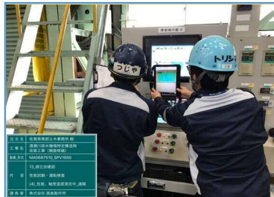
【工場試験データを写真撮影する様子】
