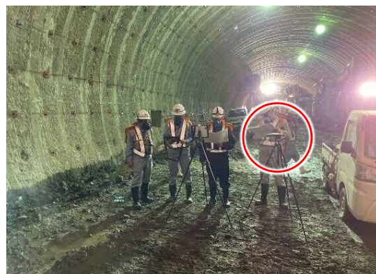
【会議用スピーカーの設置（現場側）】
