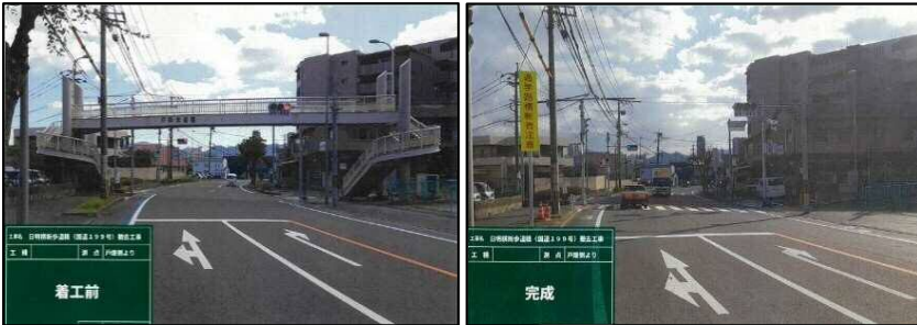
【着工前・完成】
