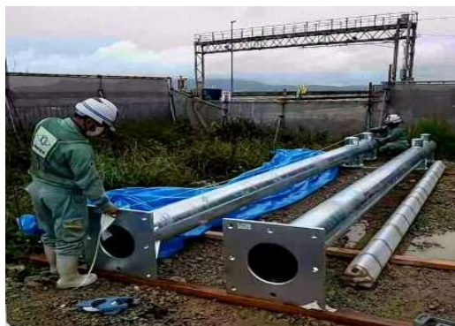
【立会状況 (現場側)】
