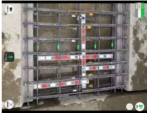
【立会状況（現場側）】
