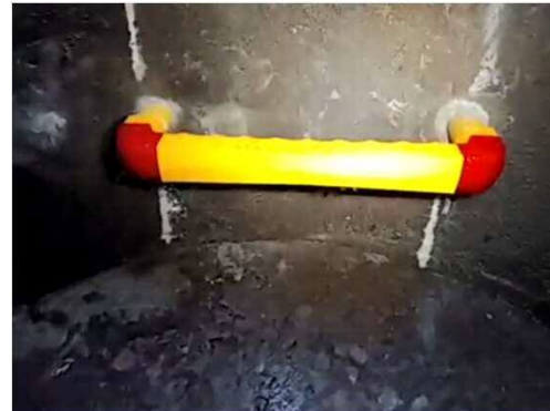
【オンライン検査（足掛金物取付確認）】
