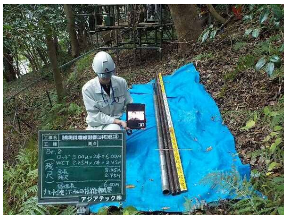
【立会状況（現場側）】
