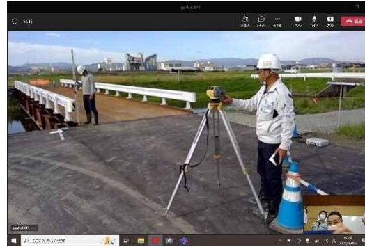
【立会状況(現場側)デジタルレベル】
