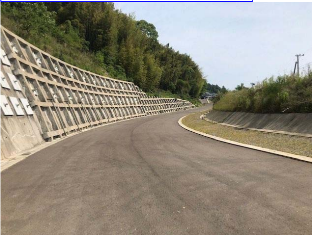
整備中バイパス区間（唐津市街側から呼子町側を望む）
