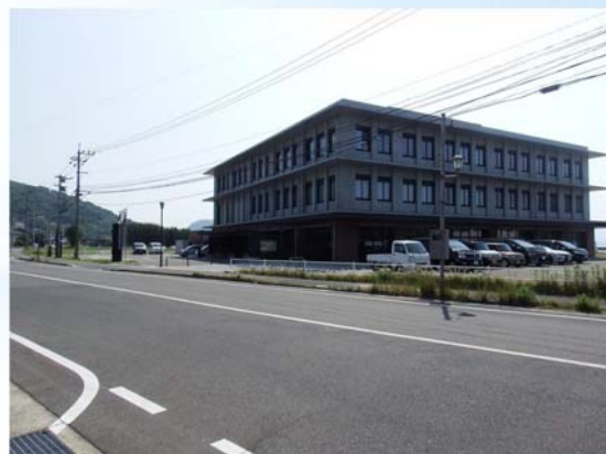
合同庁舎建替完了（H30.5）
