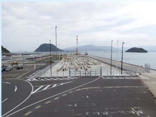
耐震強化岸壁（水深-9m）供用開始（H28.4）
