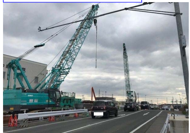
橋梁施工状況 終点側より（北側より南側を望む）
