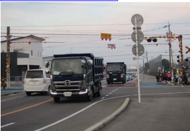
整備済区間（武雄市側より福富側を望む）
