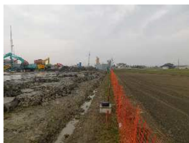
令和元年 12 月 16 日 (工事中)
