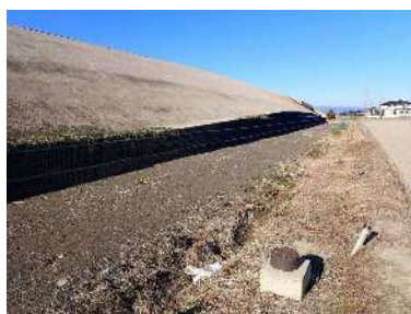
令和 3 年 2 月 8 日 (工事中)
