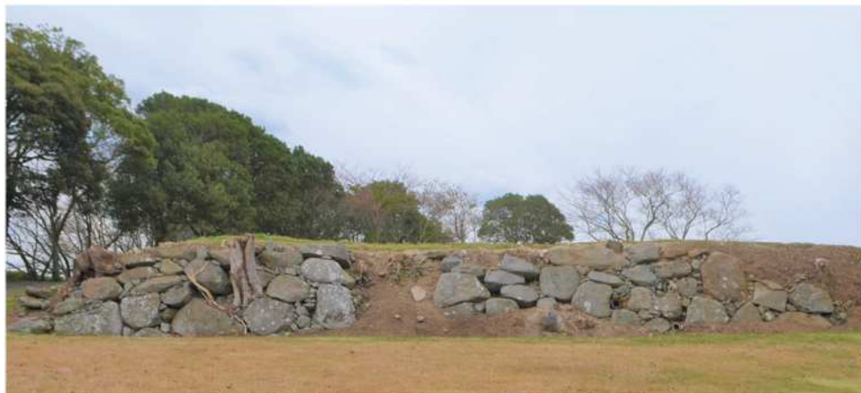
修理対象の石垣面(北東から撮影)
