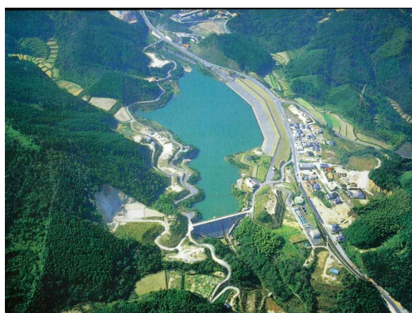
写真 1.1 平木場ダム (出典：佐賀県営ダムの概要)
