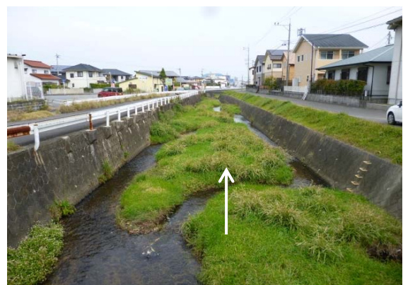
写真 5.4 中島橋から下流を望む
