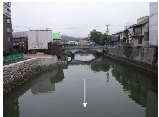
写真 2.5 市街地部での河川景観 (町田川：札の辻橋付近)
