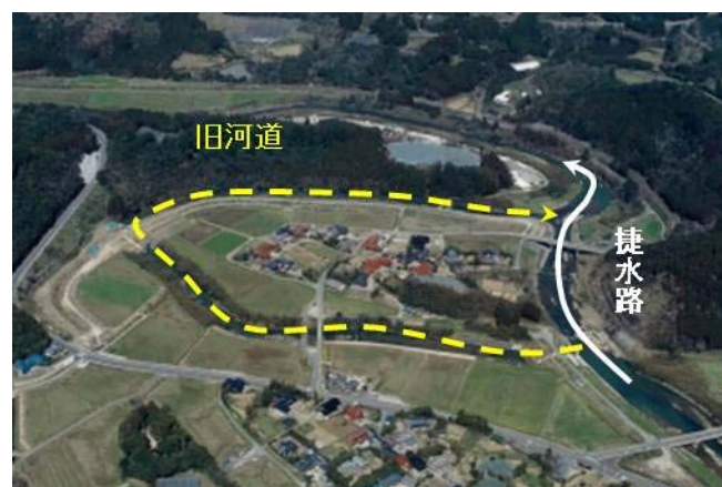
写真 1.2 駒鳴捷水路 (出典：国土交通省HP水管理・国土保全、九州の一級級河川)
