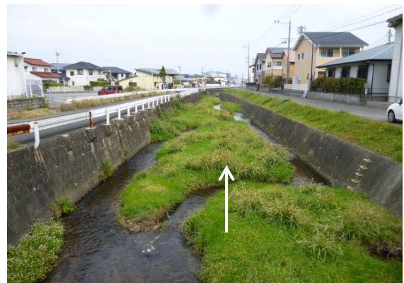
写真 5.4 中島橋から下流を望む
