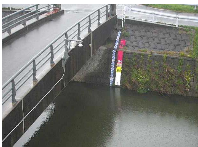
写真 6.3 水位危険度レベルの現地表示（量水標）
