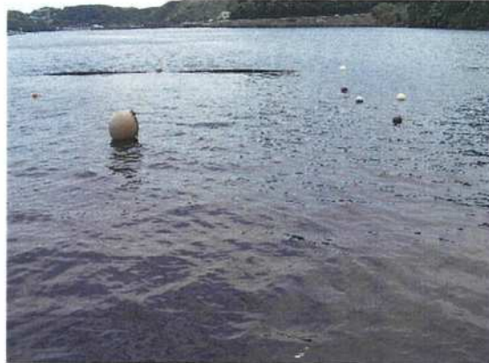
写真2 養殖施設の設置
