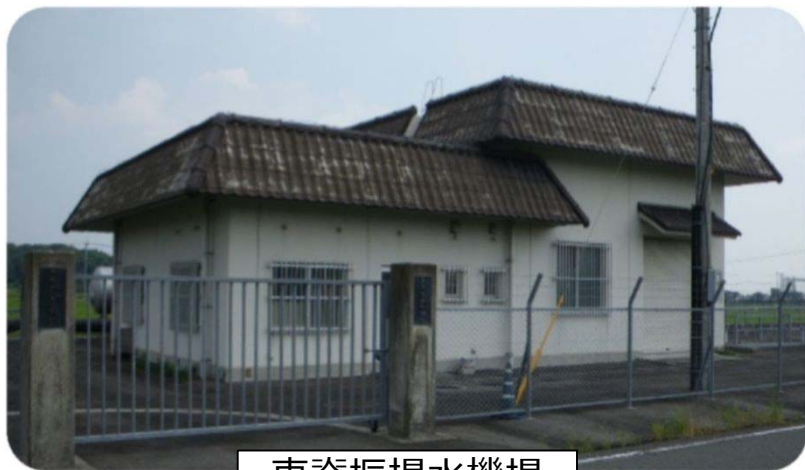
東脊振揚水機場
