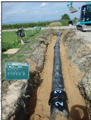
管水路の埋設状況
