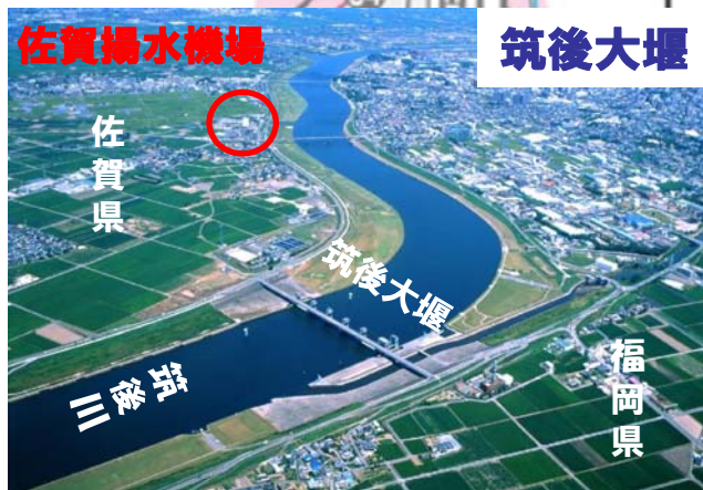
(右岸：佐賀県みやき町、左岸：福岡県久留米市)
