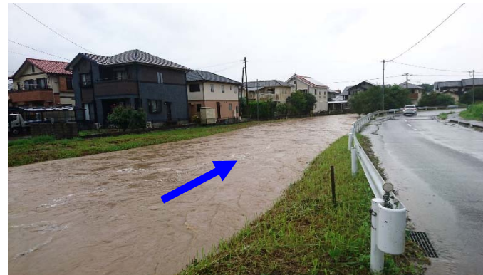
唐人川橋下流付近
