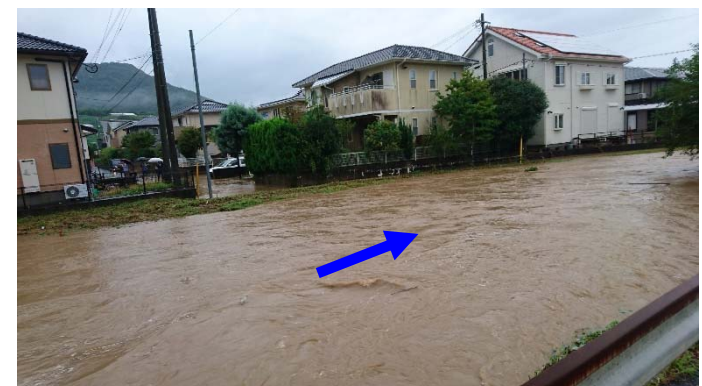
常松橋上流付近
