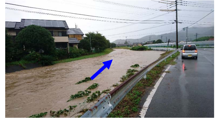
常松橋上流付近
