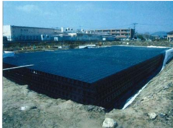
貯留施設設置状況
