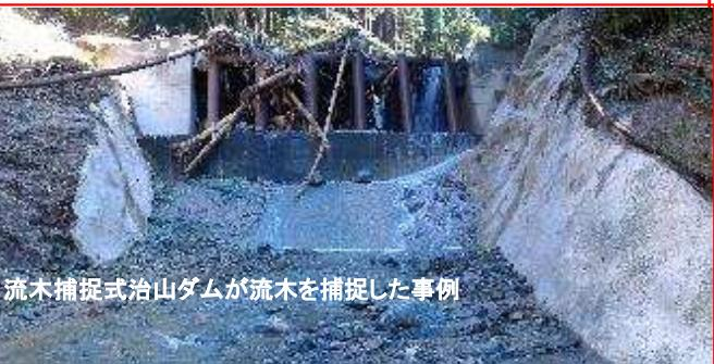
流木捕捉式治山ダムが流木を捕捉した事例
