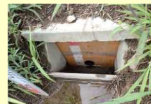
排水調節板の設置
