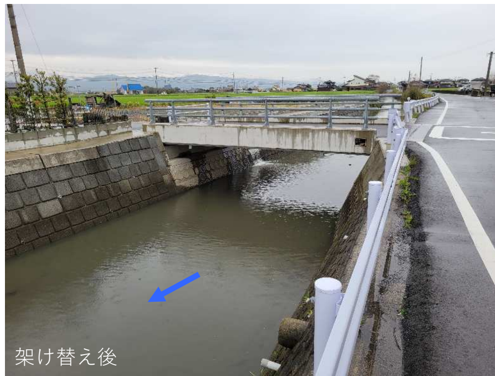
福所江（河道拡幅に伴う橋梁架け替え）
