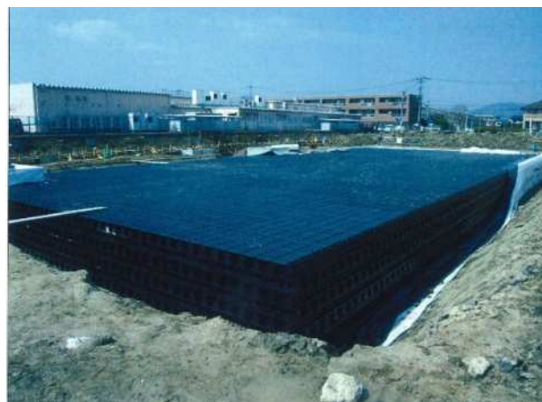
貯留施設設置状況
