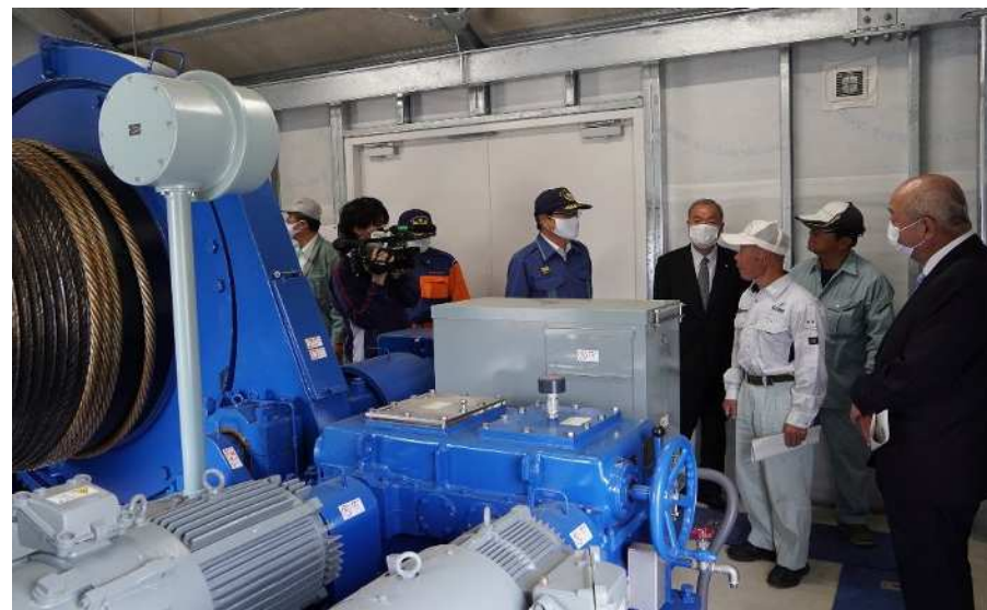
黒川町立川(水門施設内)で説明を受ける様子
