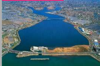
排水機場と周辺の市街地
