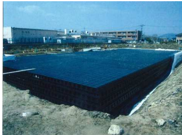
貯留施設設置状況
