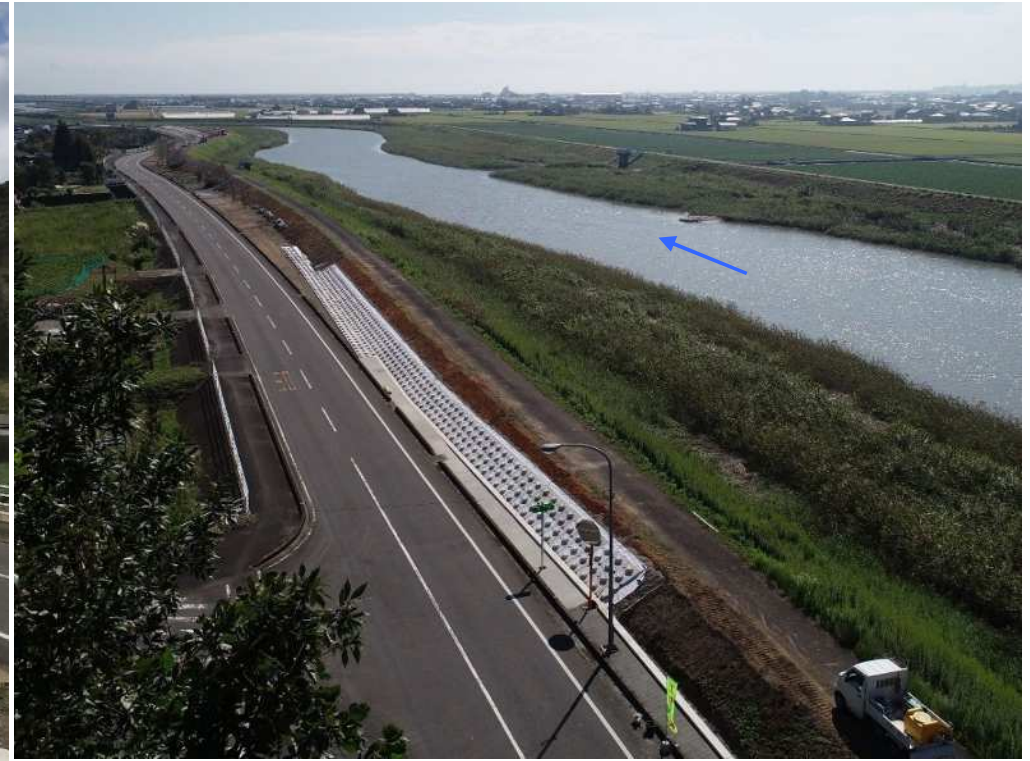
塩田川（堤防法尻補強）
