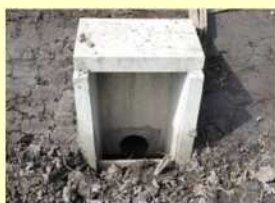
排水柵の整備
