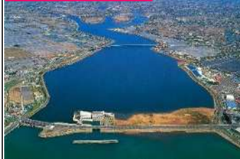
排水機場と周辺の市街地
