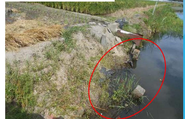
コンクリート杭柵が崩壊
