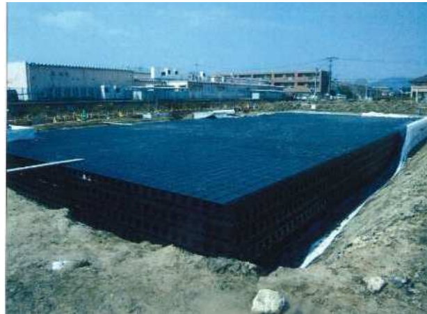
貯留施設設置状況
