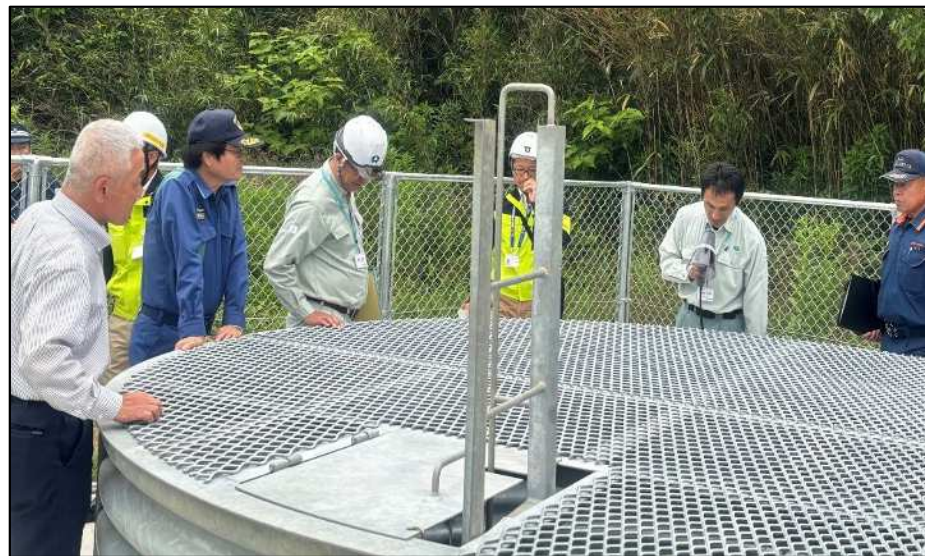
地すべり対策工事の集水井工(波多津町筒井)で説明を受ける様子
