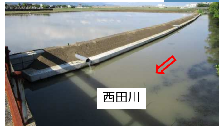
工事完成（西から東を望む）
