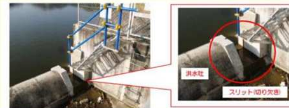
洪水調節機能を強化するためのため池の洪水吐スリットの設置状況
