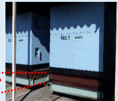
西今宿排水機場（佐賀市）
