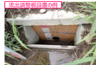
流出調整板設置の例
