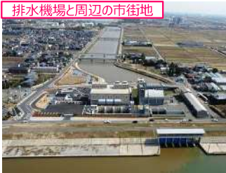
排水機場と周辺の市街地
