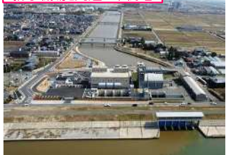
排水機場と周辺の市街地
