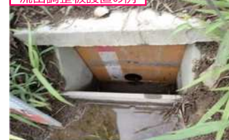
流出調整板設置の例
