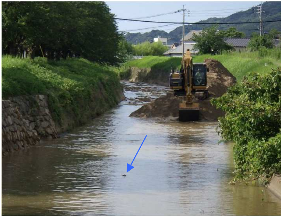
横田川（河道掘削）
