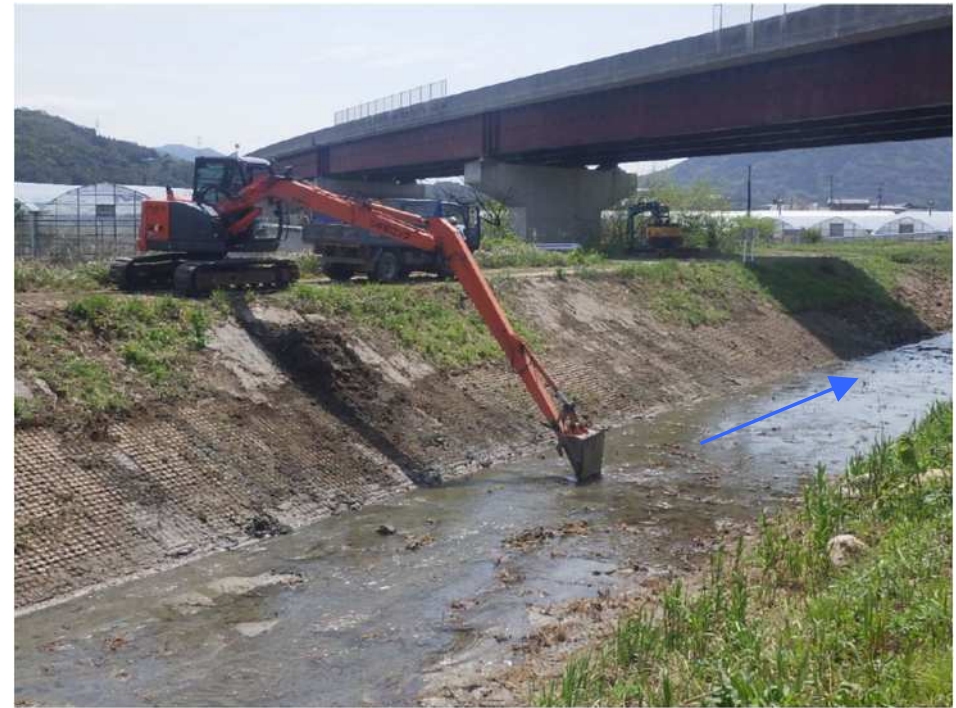
谷口川（河道掘削）
