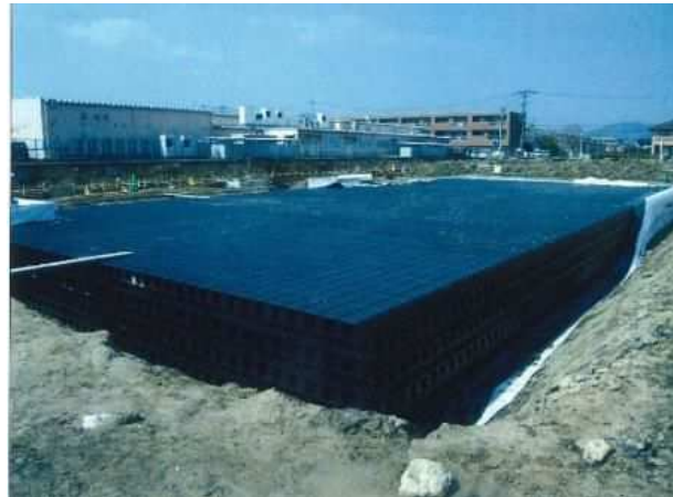
貯留施設設置状況
