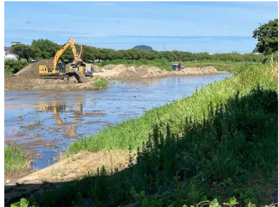
玉島川（河道掘削）
